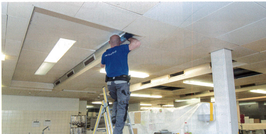
Beispiel Küche: Nach dem Entfernen aller Abluftgitter werden die verfetteten Kanäle mit speziellen Werkzeugen und hauseigenen Reinigungsmitteln gemäss Stand der Technik gereinigt. Die Gitter werden separat gereinigt, Schrauben ersetzt.
