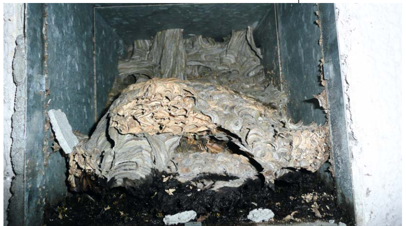
Kaum zu glauben, was für Verunreinigungen in Lüftungsanlagen zu finden sind: hier ein querschnittfüllendes Wespennest.
