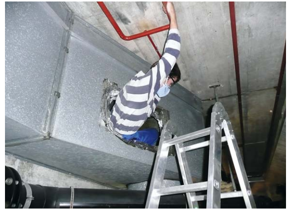
Servicetechniker müssen oft in Lüftungskanäle kriechen, um Verunreinigungen völlig zu beheben.
