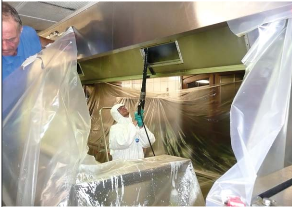
Service-Team im Einsatz bei der Reinigung einer Küchenabluftanlage.
