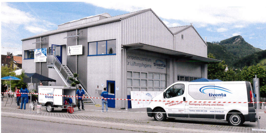
Der neue Hauptsitz der Tiventa AG in Küttigen.
